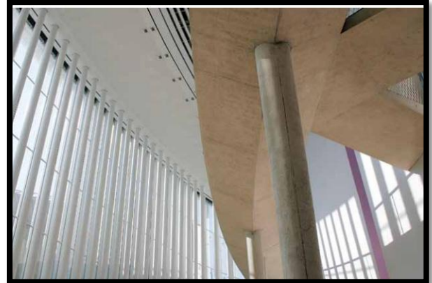
Figure 30 La façade vue d'intérieur
