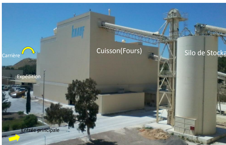
Figure 6 : une partie de l'usine de plâtre Knauf
