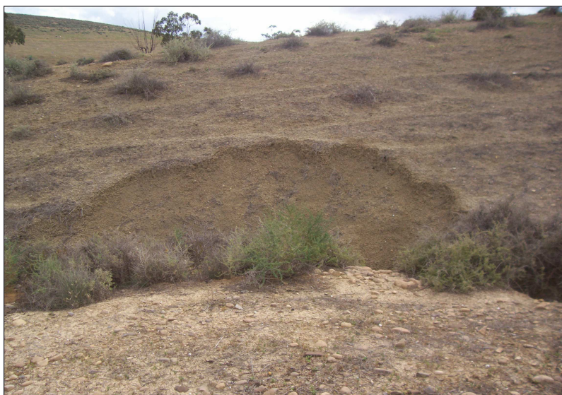
Photo 12 : glissement de terrain (Cliché Zékri et Boucif, Avril 2011)
