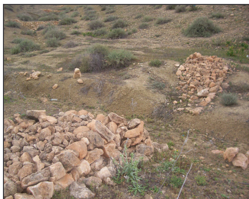
Photo n° 14 : seuil en pierres sèches détruit dans sa partie centrale et reprise de l'érosion régressive (Cliché Zékri et Boucif, Avril 2011)
