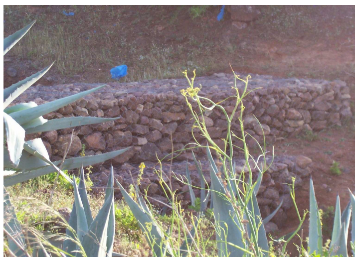
Fig .11: gabion (région de Oulhaça, Cliché Boucif, 2011)
