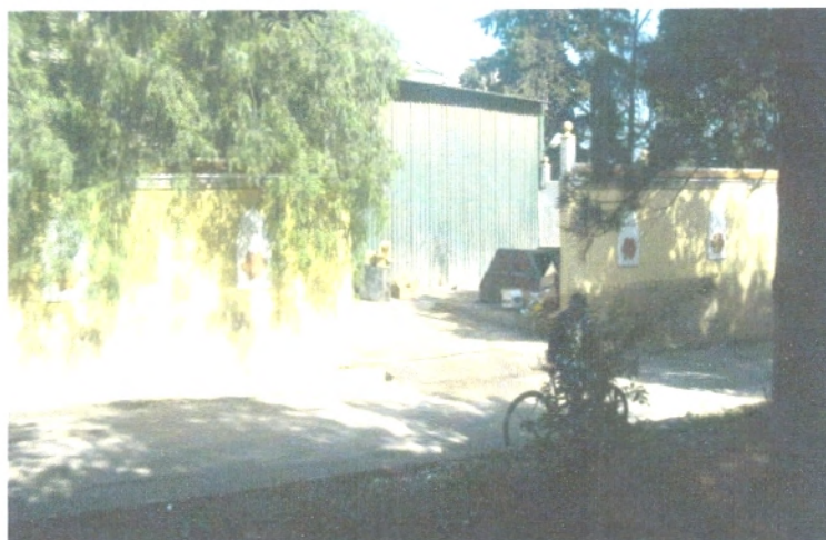
Photo n°01 : La zone de dépôt final
