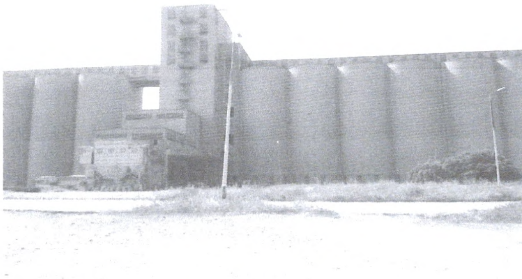
Figure 07 : silos en béton armé de la CCLS de Abou-Techfine (Tlemcen).
