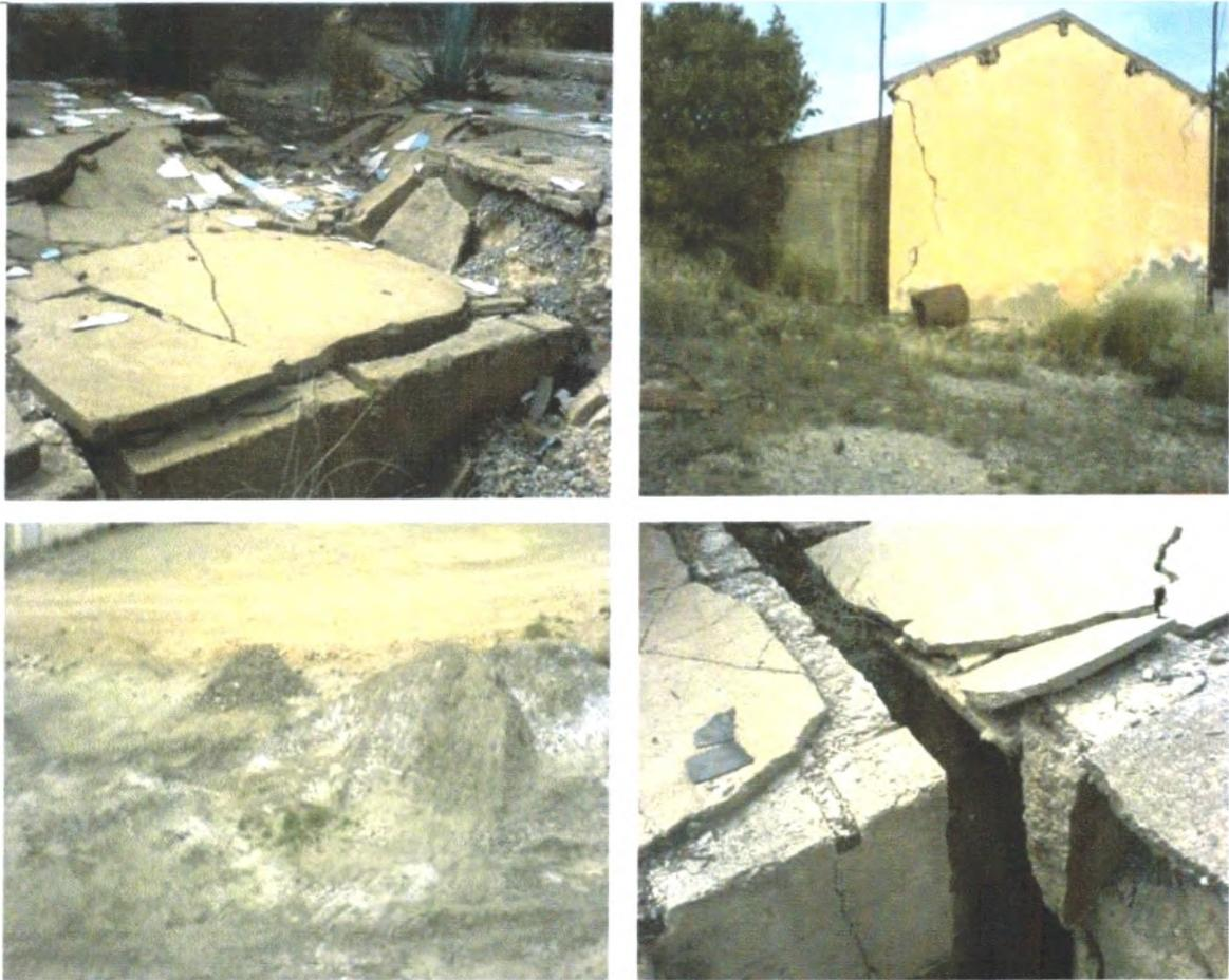
**Figure 24** : quelques photos montrant une fissuration du sol et une fracturation d'un mur (BOUKELLOUL.M.L, 2007).
