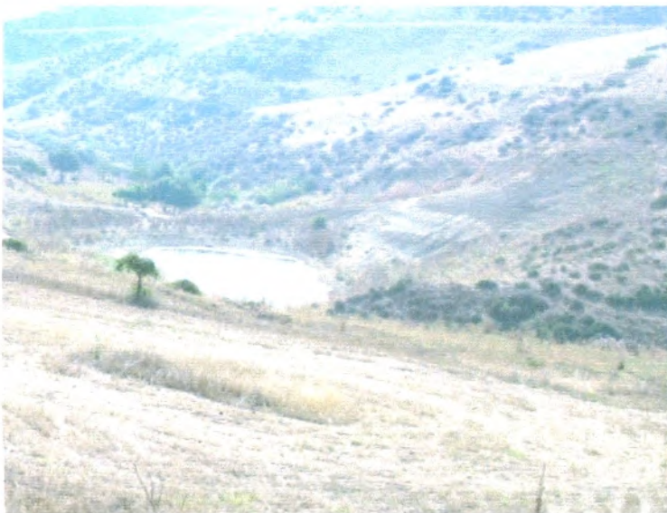
Photo n°3 : Correction torrentielle en terre utilisée comme un point d'eau pour l'abreuvement du cheptel.
