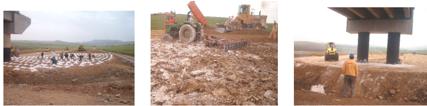
(a) Épandage de la chaux
