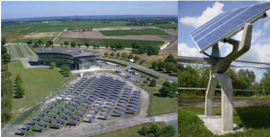
**Fig. VI.10 La centrale solaire photovoltaïque à "suiveurs solaires" de Martillac (France, Gironde).**
