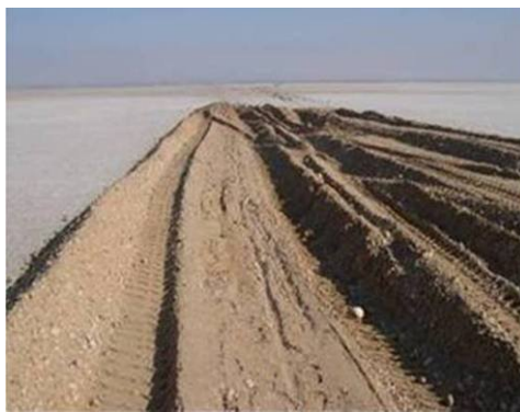
Figure 6. Difficultés de mise en place de la première couche sans géotextile
