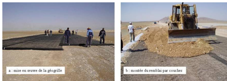
Figure11. Mise en place de la géogridde
