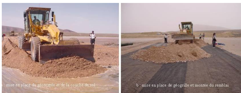
Figure 5. Mise en place du géotextile et de la géogrille
