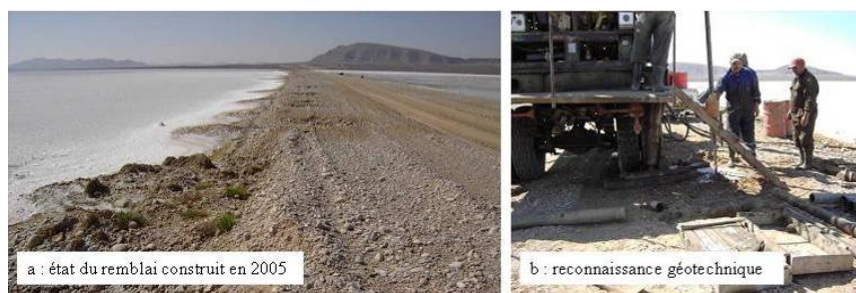
Figure 7. Reprise des essais de reconnaissance géotechnique en 2007
