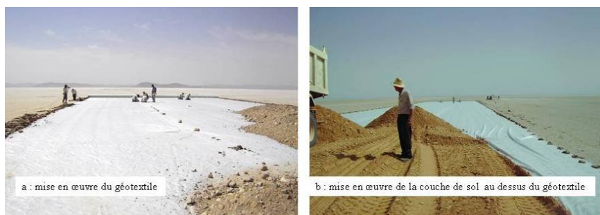
Figure10. Mise en place du géotextile
