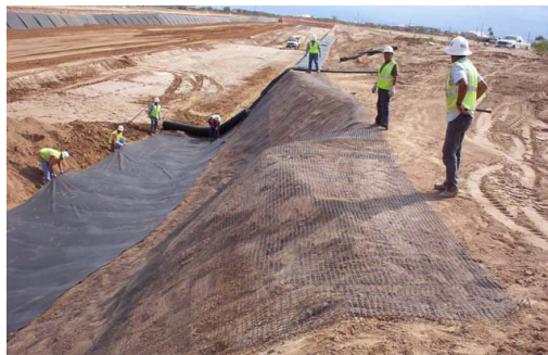
Figure 4. Méthode d'atténuation de fissures sur une chaussée, (photo par Ken Euge).
