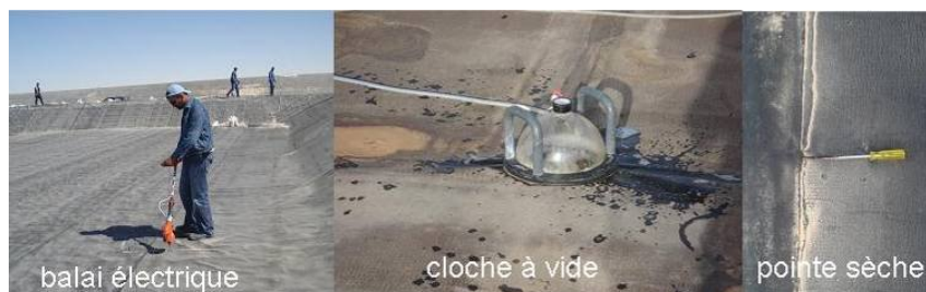
Figure 14. Différents contrôles effectués sur chantier
