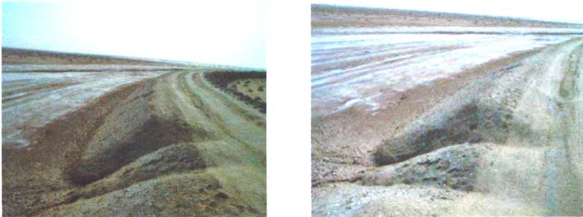
Fig. 36 - Entailles de surverse dans le revers de la digue de retenue
