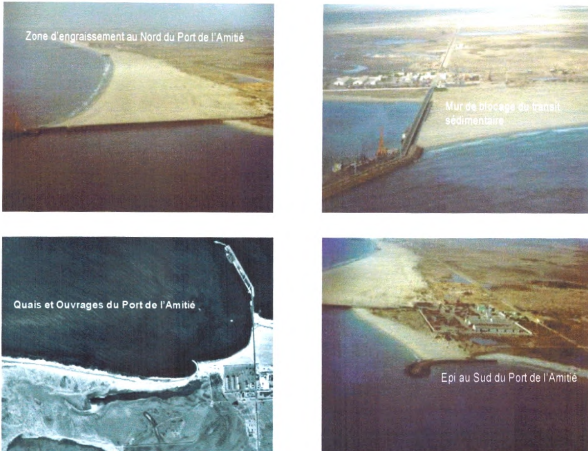
Fig. 35 - les infrastructures portuaires du port d'amitié
