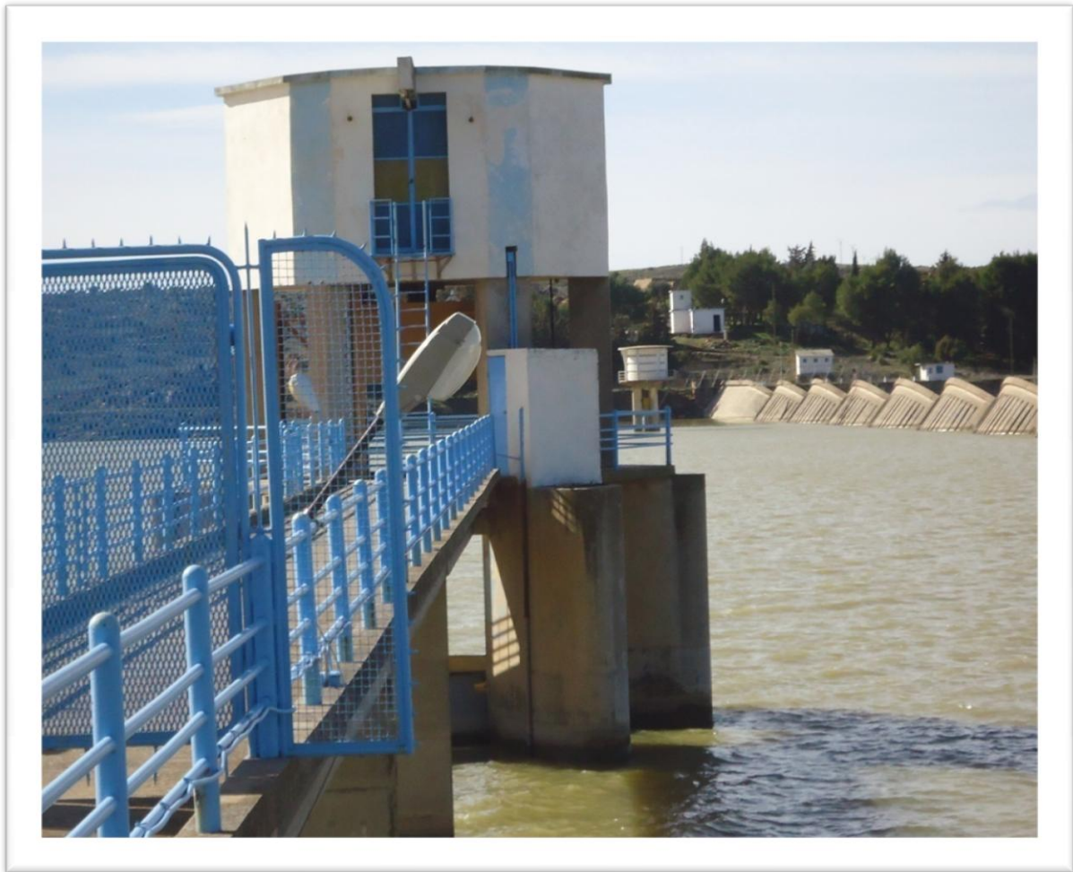
FIGURE II-4 : Photo de la vanne de décharge intermédiaire prise-le 15.05.2014.
