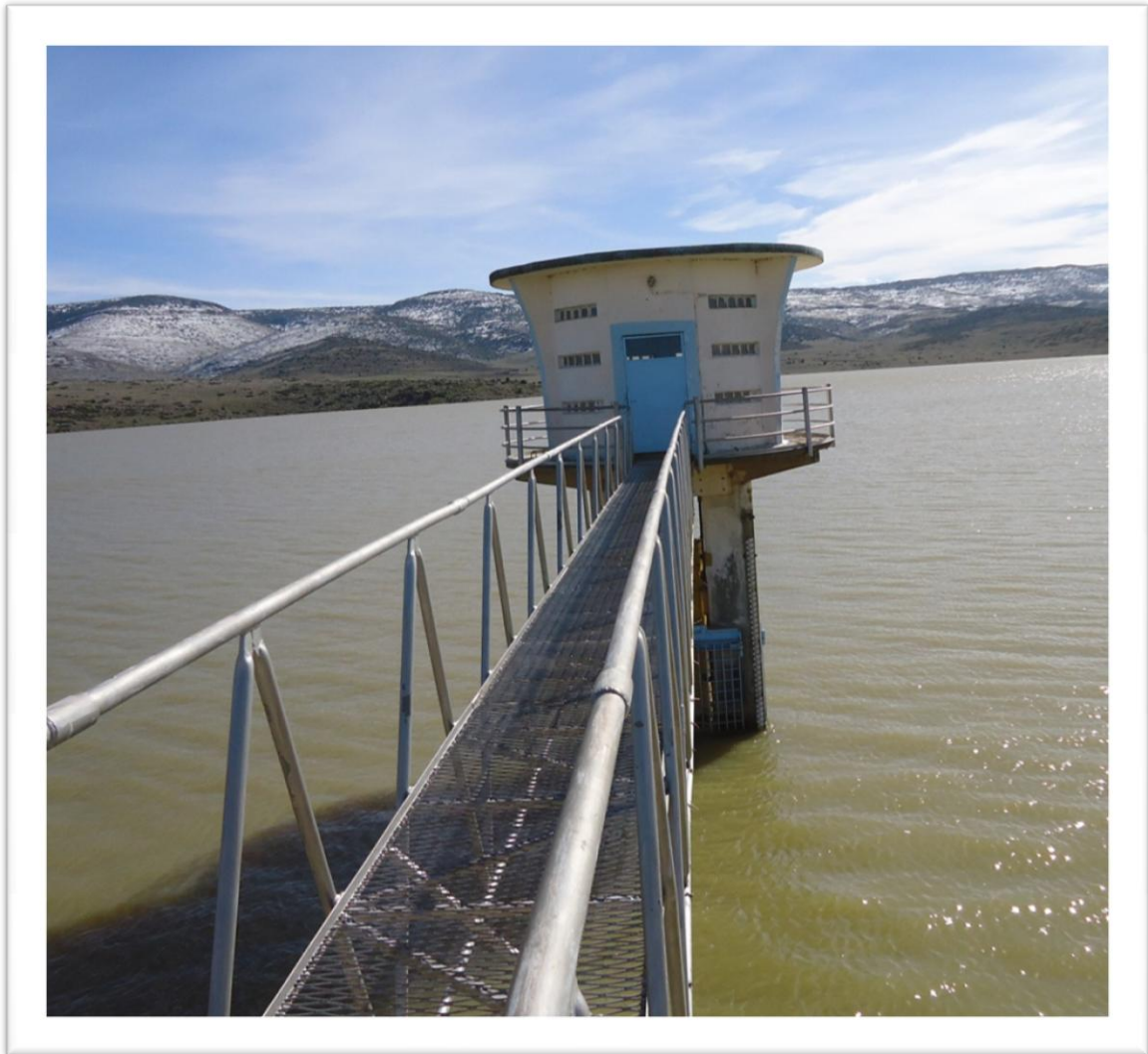
FIGURE II-6 : Photo de la prise d'eau prise le 15.05.2014.
