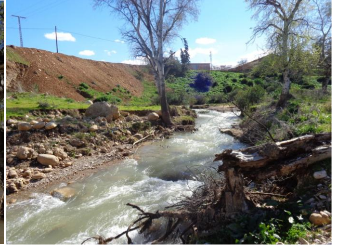
Photo 23: vue générale de la station Ch4 (aval)
