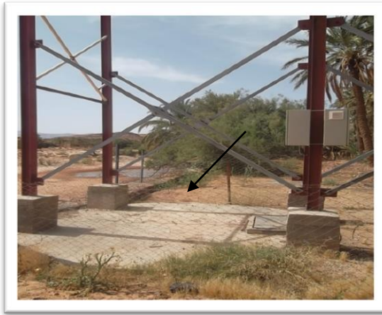
Fig. z9: Chambre de captage (Cliché MAHMOUDI S 2013)
