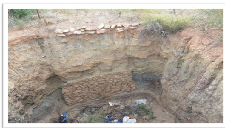
Fig. r : Affaissement d'un puits (Moghrar) (Cliché MAHMOUDI S 2013)
