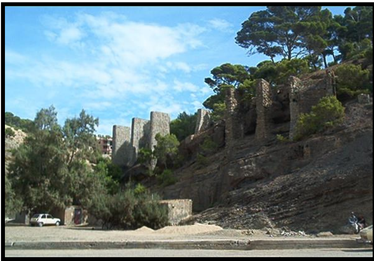
Murs porteur qui supportaient les chemins de fers
