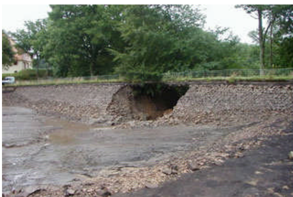
Figure 1.3. Destruction des ouvrages en terre par érosion interne (citée par Alhaddad, 2011)
