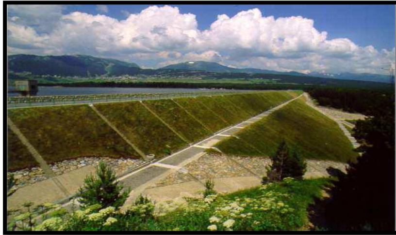
Figure I.3 : barrage en terre (barrage homogène)
