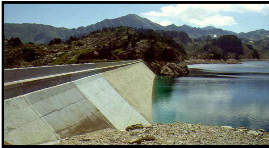
Figure I.5 : barrage en terre (barrage à masque).
