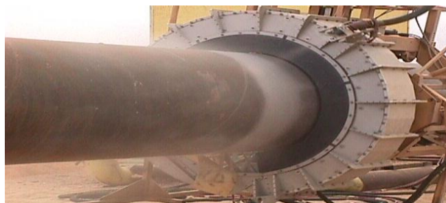
Figure 2.8 : Machine de sablage automatique(STT).
