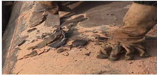
Figure 2.6 : décapage manuel (STT)
