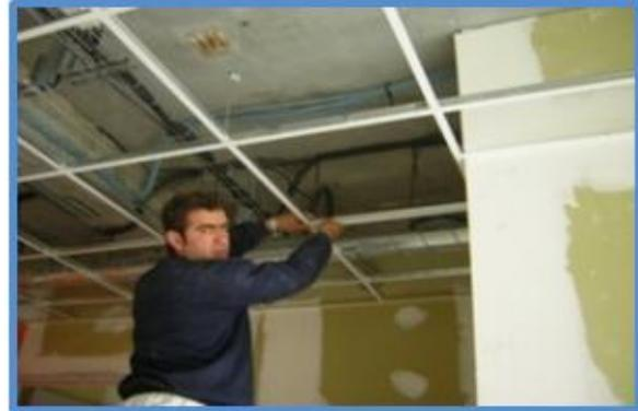
Pour ces raisons notre choix s'est porté sur le faux plafond en plâtre ; on va utiliser es plaques de plâtre d'une longueur de 120cm, d'une largeur de 60cm et d'une épaisseur de 1.5cm.
