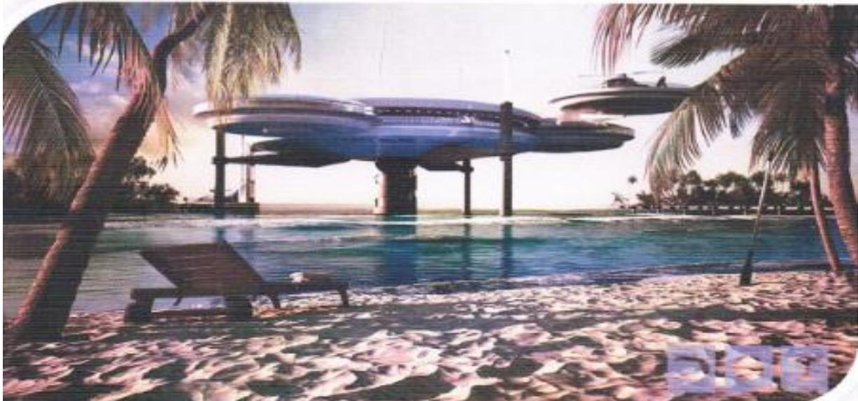
Le complexe a été conçu pour résister aux conditions météorologiques les plus difficiles et à un éventuel Tsunami. En cas de situation d'urgence, les disques immergés peuvent remonter à la surface et les disques satellites peuvent se détacher de la structure principale pour faire office de bateaux de sauvetage.
