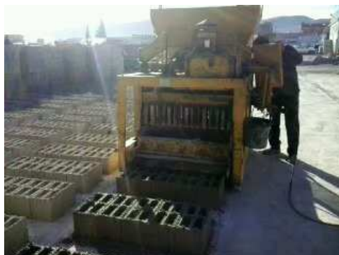
Fabrication des blocs
