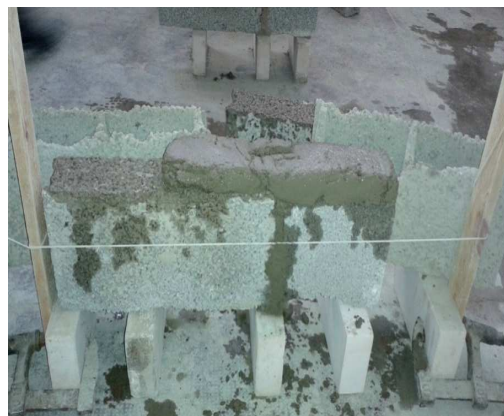
Figure 3.13 Première couche du mortier
