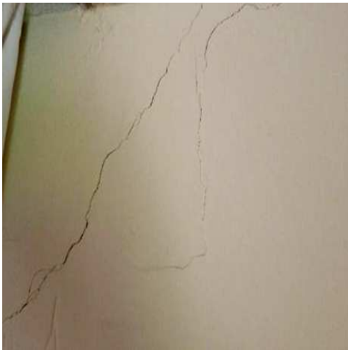
Exemple de fissures dues au cisaillement (France, 2011)
