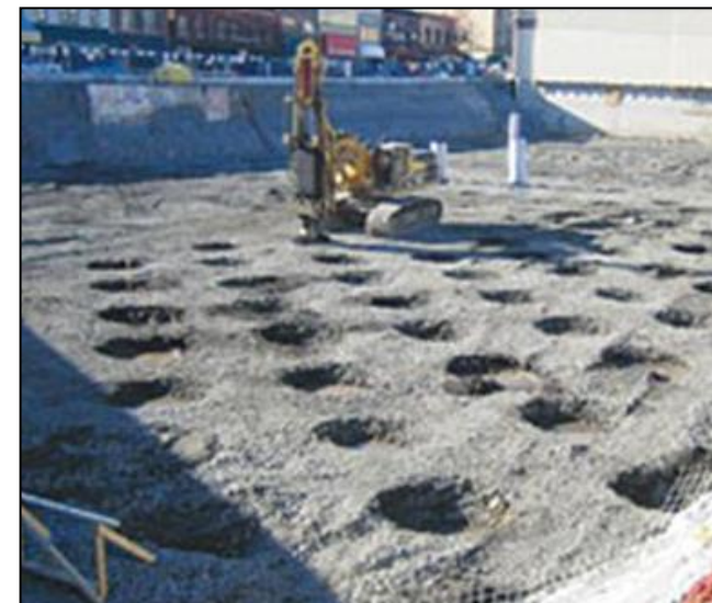
Illustration d'un chantier en compactage
