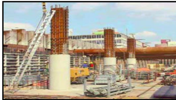
Figure 163 Photo De Chantier
