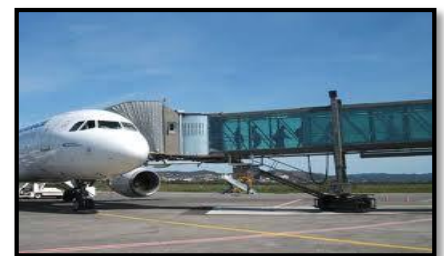
Figure142 : Accès Par Passerelle
