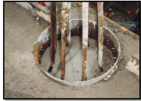
Figure 166 : Coffrage Poteau Mixte
