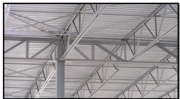
Figure 168 : Structure Avec Poutres En Treillis
