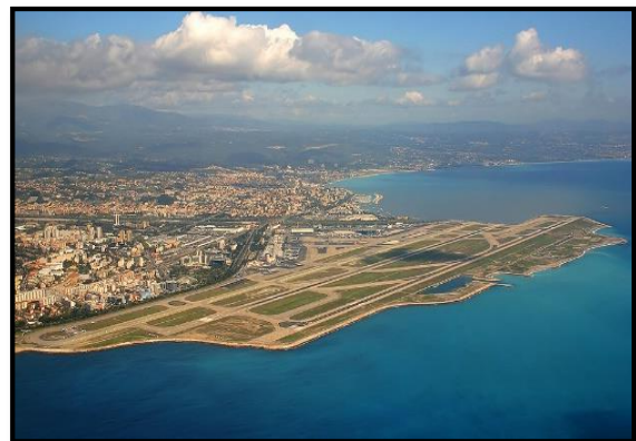
Figure 87 : Photo Aérienne De L'Aéroport De Nice
