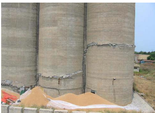
(b) Les cellules en béton endommagées des silos de grains de la société Eriad de Corso
