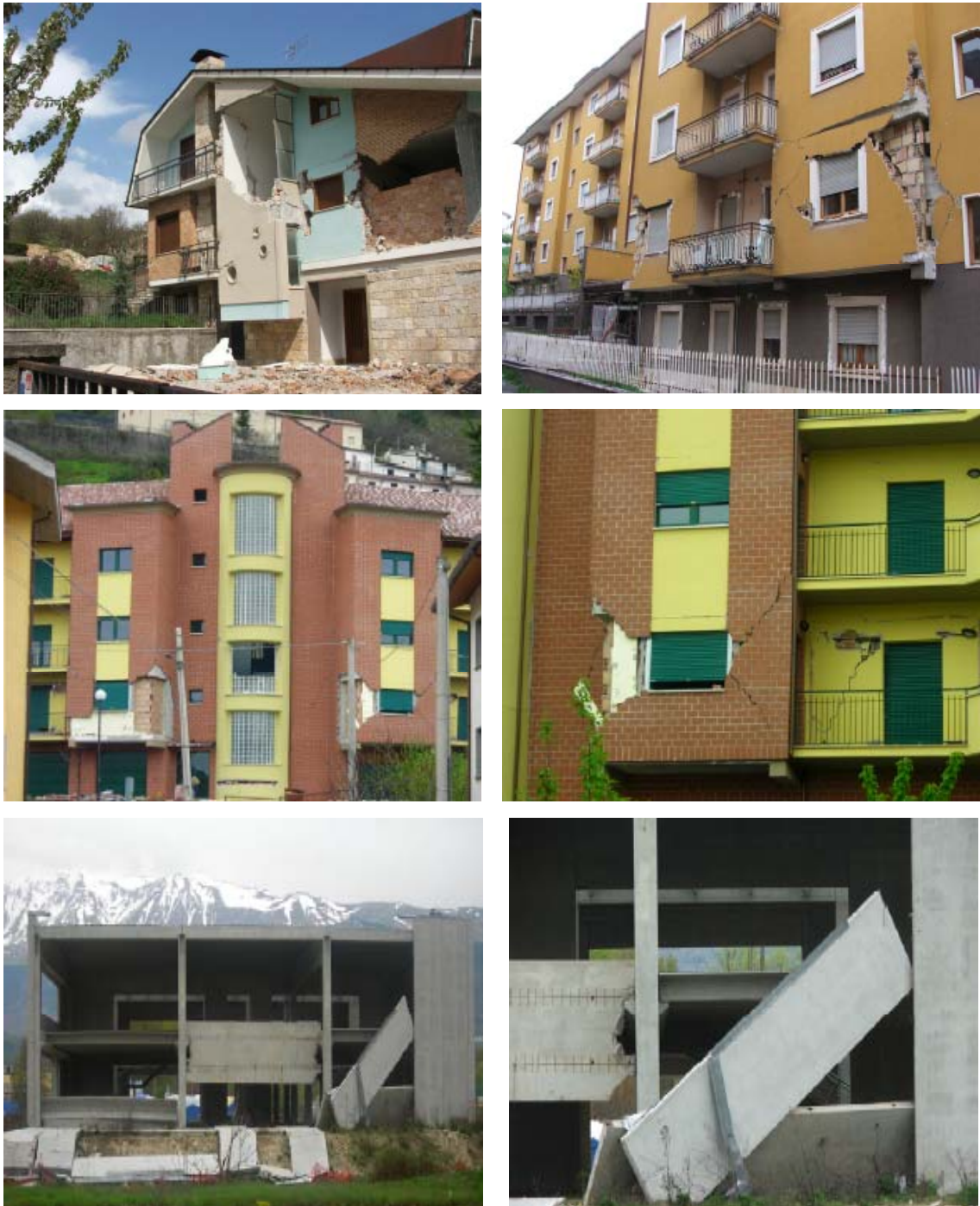
Figure 2.16 Effondrements des structures en béton armé, en maçonnerie, et des éléments non structuraux durant le séisme de L'Aquila (2009) (Di Sarno et al 2011)
