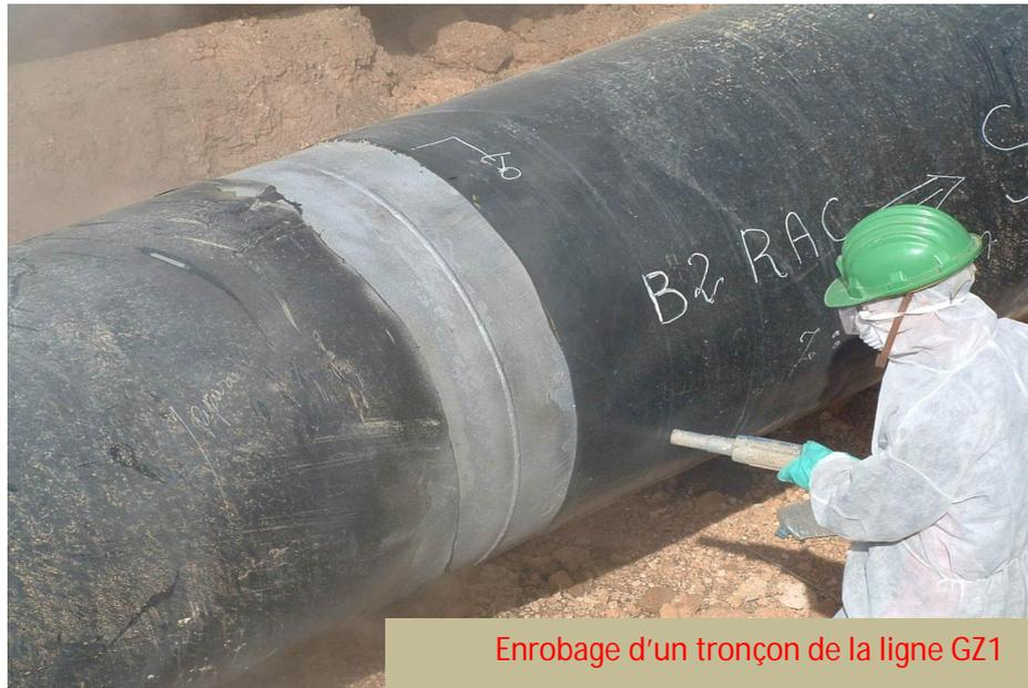
**Figure 22 :** Mise en place des revêtements sur la ligne GZ1
