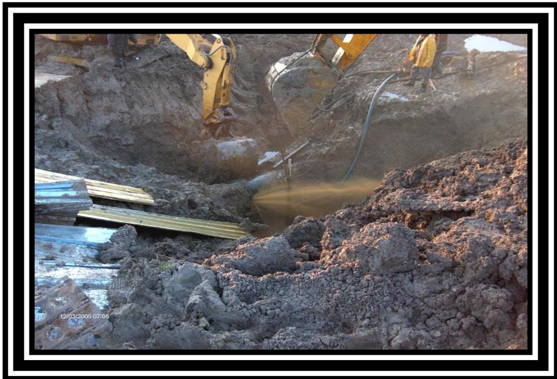
**Figure18** : Dégâts causés par les fuites des hydrocarbures des pipelines
