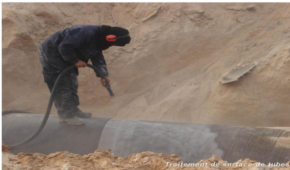
**Figure 21** : Traitement de surface d'un tronçon du gazoduc GZ1
