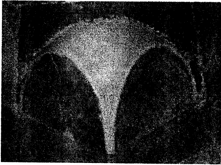
(اللوحة رقم 26): منظر لمنطقة إنتقال القبة من المربع الى المضلع بضريح سيدي إبراهيم المصمودي
