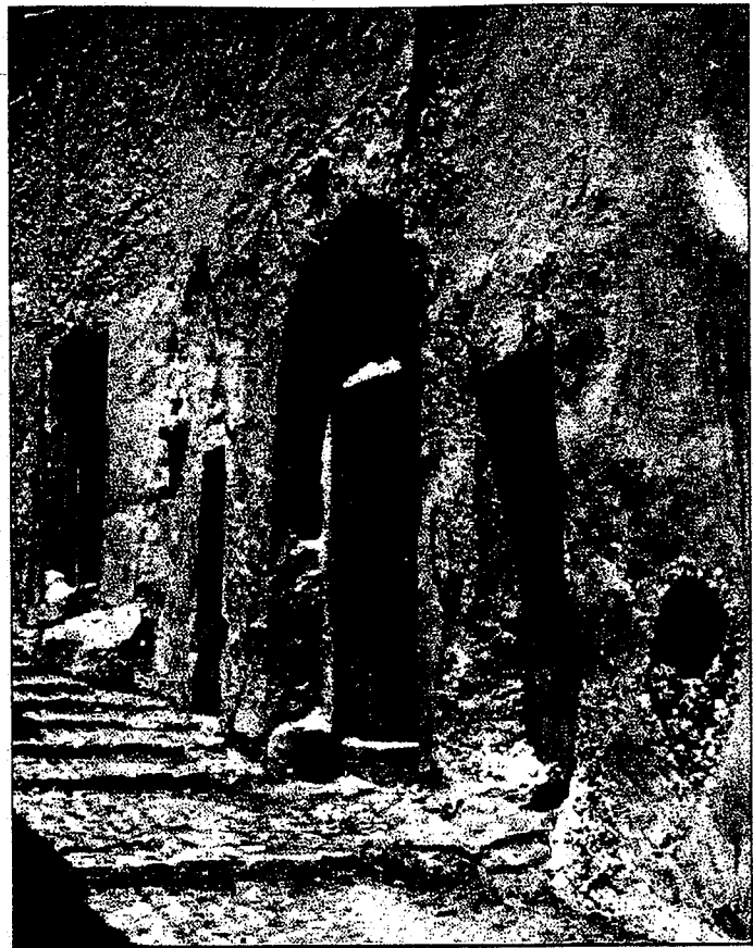
الصورة رقم 29 : واجهة مسكن تقليدي
