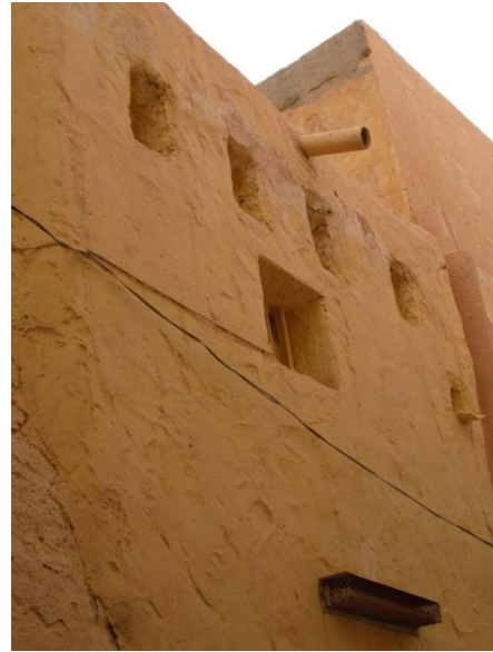
الصورة رقم (49): الميزاب أو المزراب لصرف مياه المطر
