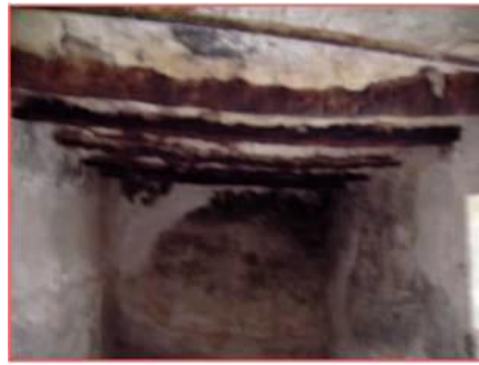
التسقيف بعوارض خشب النخيل
