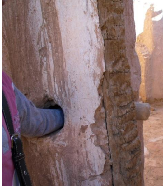
الصورة رقم (21): فتحة إغلاق باب المدخل الرئيسي للمسكن - قصر موغل
