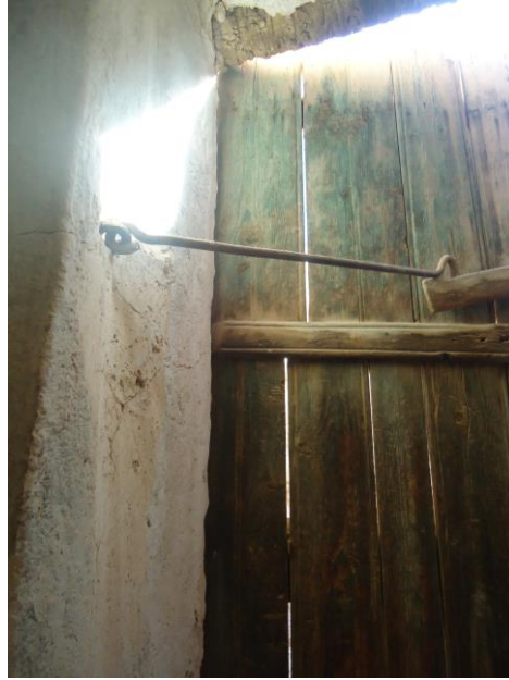
الصورة رقم (84): قضيب معدني لتثبيت باب المدخل الرئيسي - قصر ورثلة
