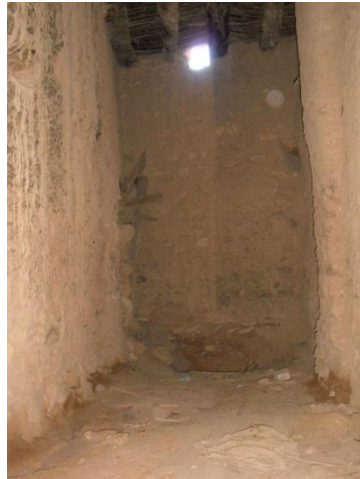
الصورة رقم (23): فتحة لإضاءة وتهوية الغرفة - قصر تاغيت
