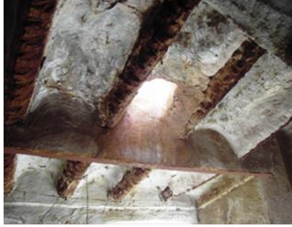
الصورة رقم (83): تقنية التسقيف بالعوارض الخشبية والأقبية نصف برميلية - قصر ورثلة
