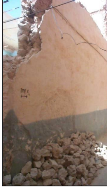
الصورة رقم (65): استعمال الحجارة الخام في عملية بناء الجدران
