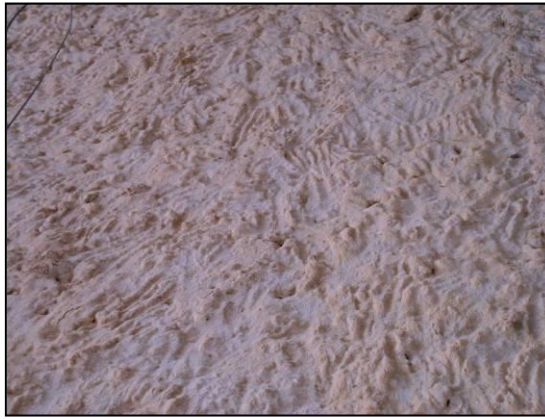
الصورة رقم (70): تقنية التليس باستخدام اليد - وادي مزاب
