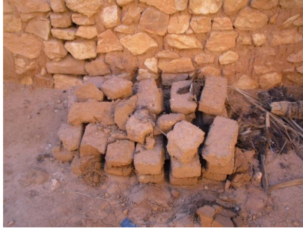
الصورة رقم (30): تنوع مواد البناء (الطوب والحجارة)
