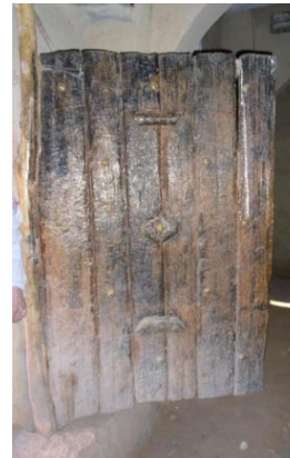
الصورة رقم (18)، (19)، (20): أبواب مصنوعة بعوارض خشب النخيل إلى جانب الطبطابة
