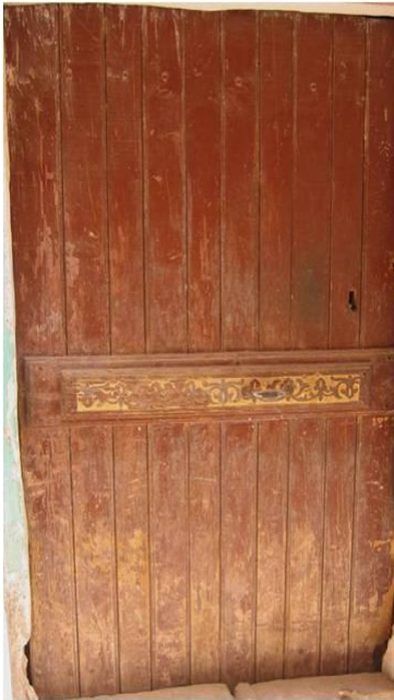
الصورة رقم (47): الباب الخشبي للمدخل الرئيسي والعارضة الأفقية المزخرفة
