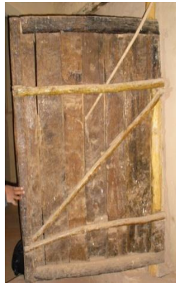
الصورة رقم (18)، (19)، (20): أبواب مصنوعة بعوارض خشب النخيل إلى جانب الطبطابة
