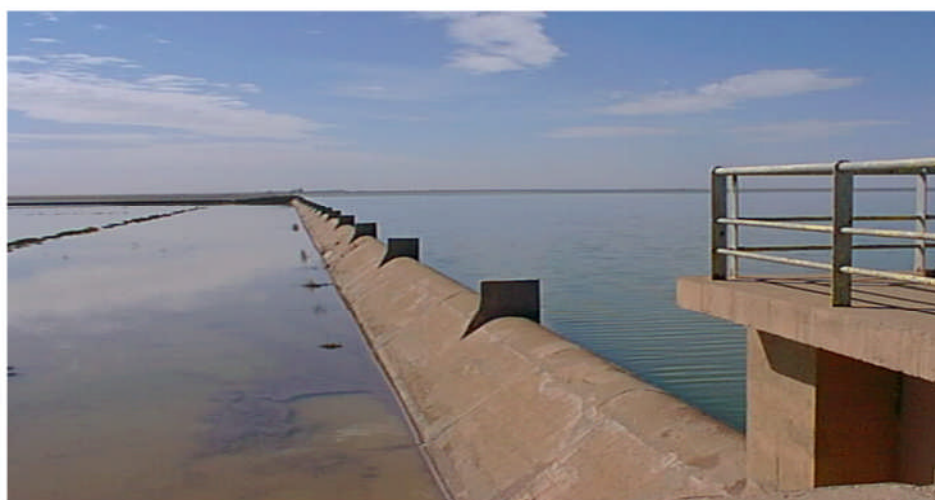
Photo .4.4.Digue sud du barrage Boughzoul
