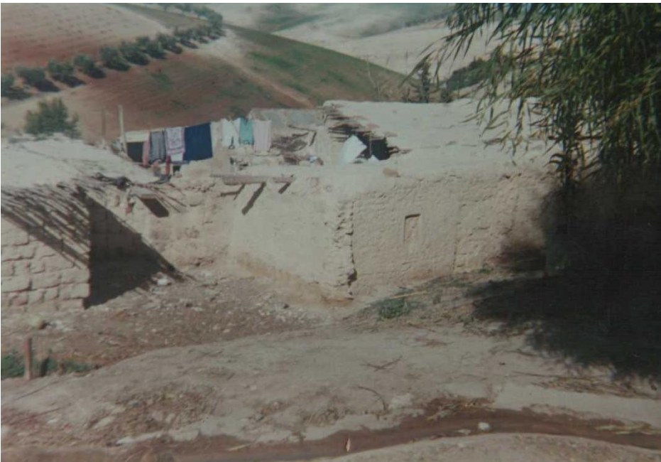
صورة تظهر جدران من الطوب و شكل الأسقف.
