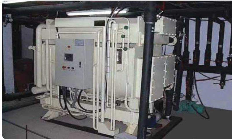
Figure IV.8: Machine à absorption- Hôtel de Rethymnon – Crète (Grèce)[18]
