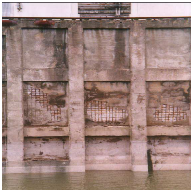
(a) quai en zone de marnage (France).
