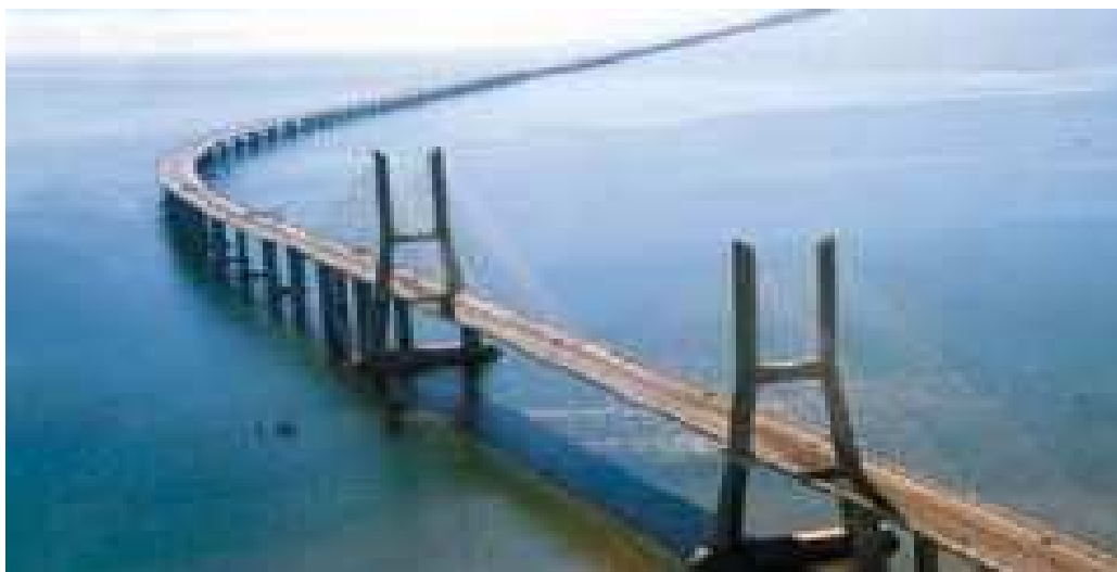
Photo 2 : Pont vasco de gamma sur le Tage à Lisbonne au Portugal réalisé en 1998 pour une durée de vie de 120 ans ; (Indicateurs de durabilité : coefficient de diffusion par la méthode Tang Luping D_{app} = 12 \cdot 10^{-12} \text{ m}^2 \text{ s}^{-1} et Perméabilité à l'oxygène < 12 \cdot 10^{-17} \text{ m}^2 ) (Hornain, 2006).
