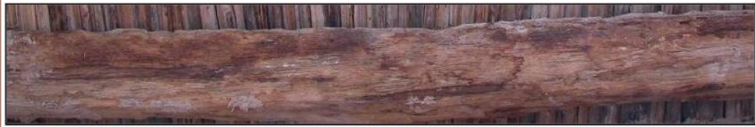
Poutre en bois de palmier Origine : Ferkla, s. XIX, ref. 583.
