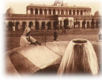
Ancien puits artésien
