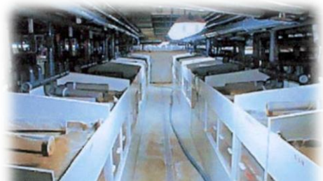
Circuit du traitement de l'eau des aquariums
