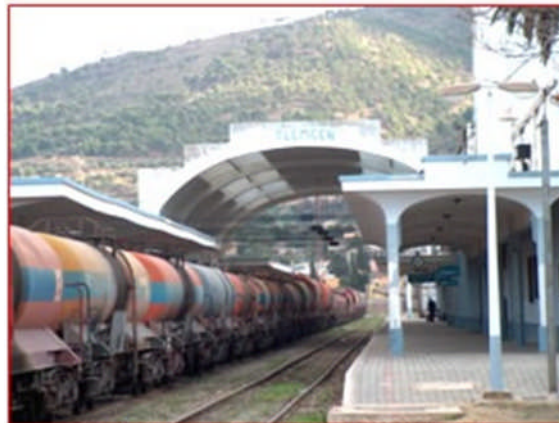
vue sur les quais et la marquise
