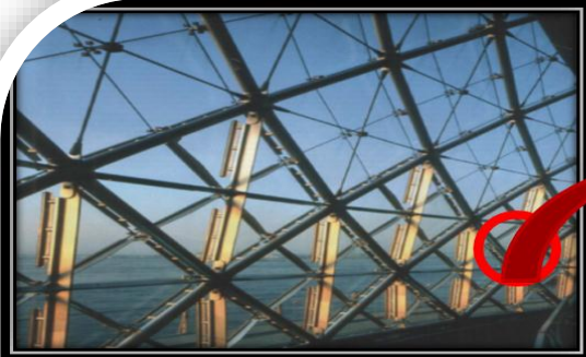
Articulation poutre tridimensionnelle – Poteaux métallique
