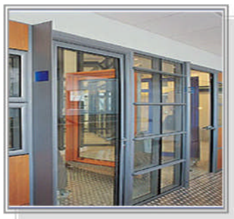
Porte en verre, monté sur ossature secondaire.
