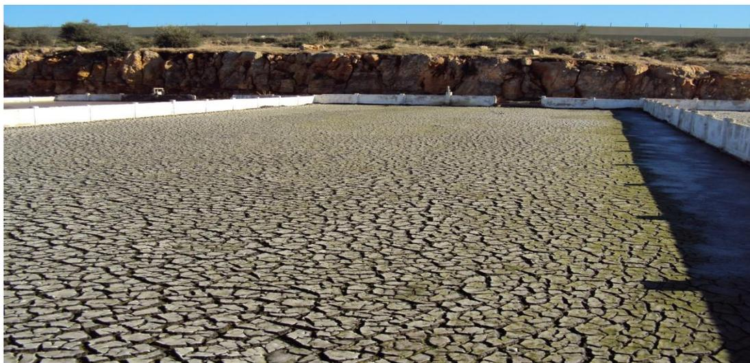
**Figure IV.13:** Vue d'un lit de séchage rempli de boues
