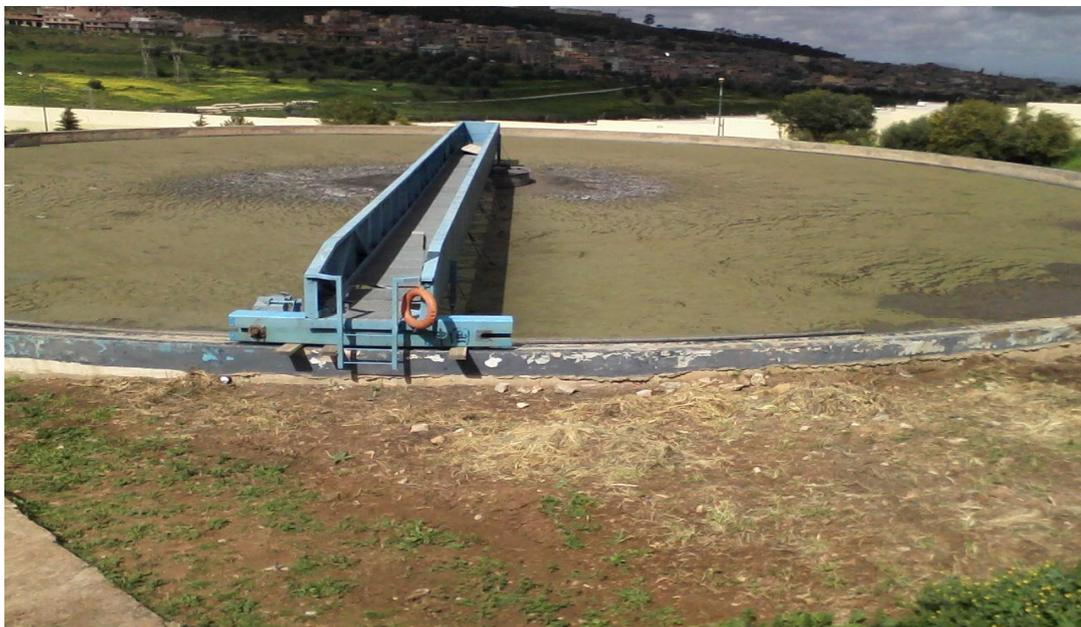
**Figure IV.10:** Photo d'un Clarificateur [21]
