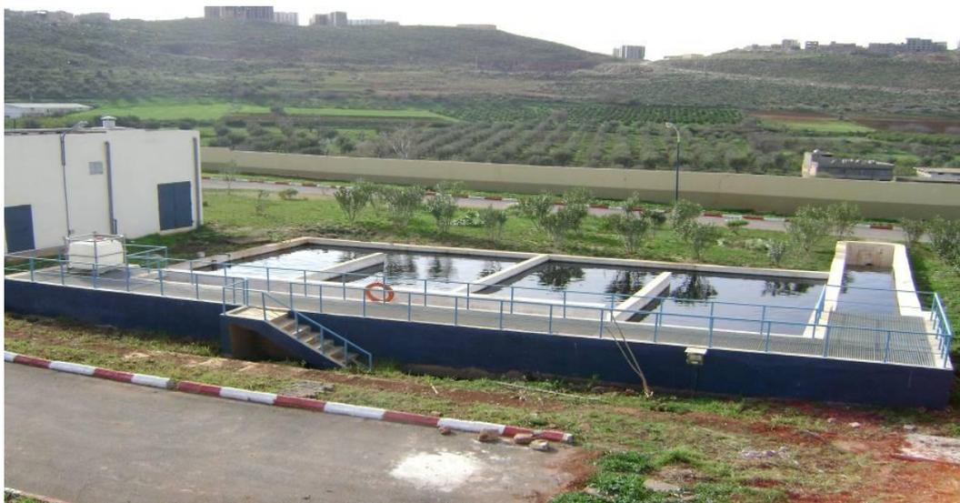
**Figure IV.11:** Photo des bassins de chloration [20]
