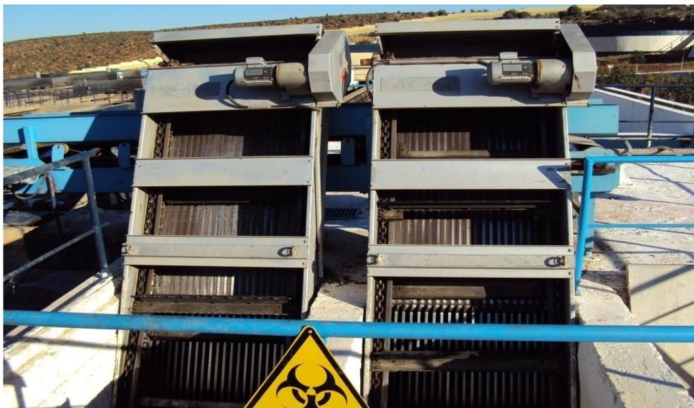
**Figure IV.6:** Grille mécanisée (2 unités) [21]
