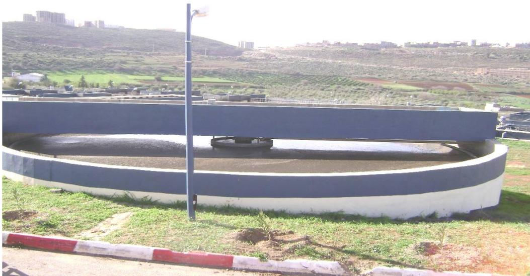
**Figure IV.12:** Photo d'un épaisseur [20]
