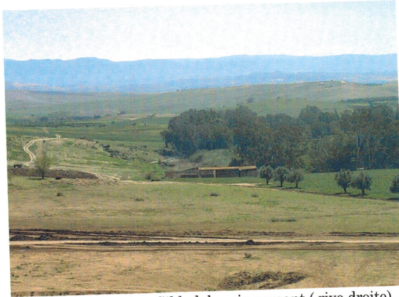
Photo 7.2 Barrage Sikkak bassin versant ( rive droite)
