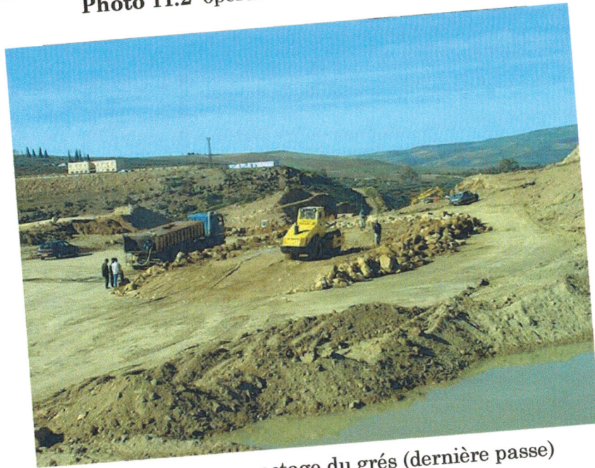
Photo 11.2 opération compactage du grés
