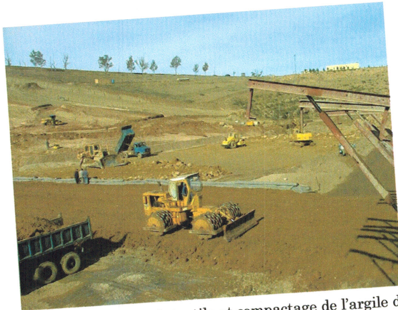
Photo 9.1 Mise en place du géotextile
