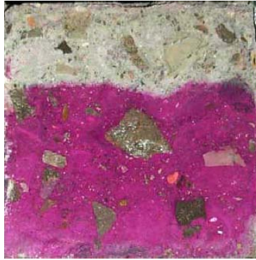
Figure 2.11 Mise en évidence de l'épaisseur carbonatée par la solution de phénolphaléine
