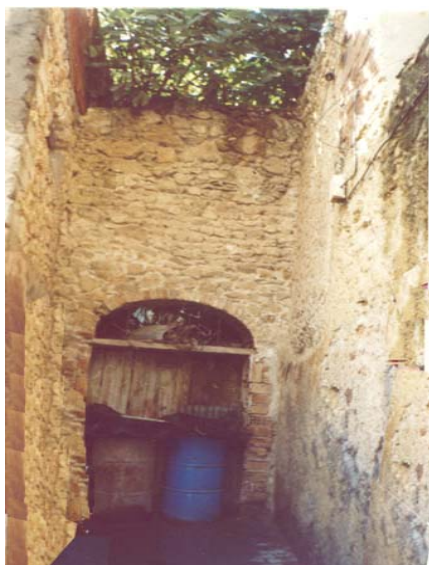
Photo 26: L'entrée du fondouk côté ouest de la mosquée de l'El-Ria.
