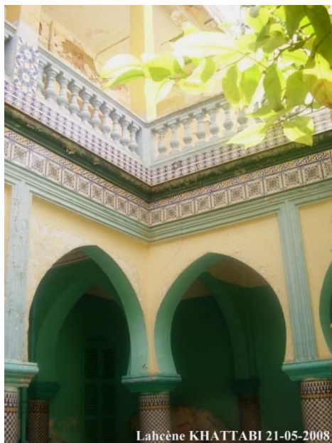
Photo 29: West Eddar de la maison Sanhadji à côté de la Grande Mosquée (Exemple d'une richesse de décoration). (Source : Auteur)
