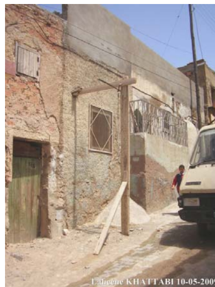
Photo 41 : Mouçalla Sidi Saïdane lors des travaux de restauration (vue d'extérieur). (Source : Auteur)
