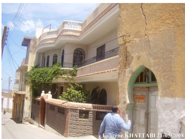
Photo 45: Maison située au quartier El-Kherba.
