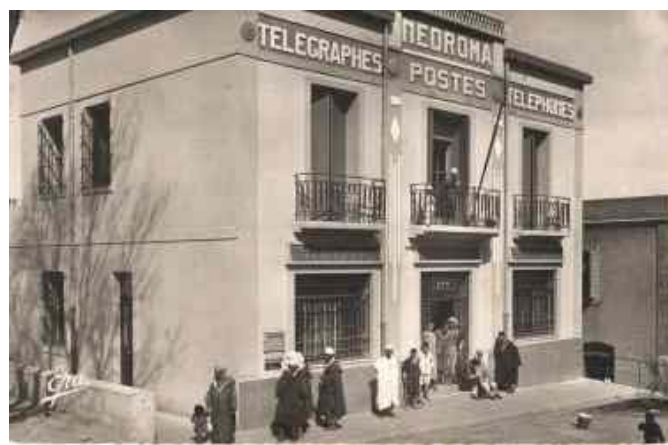
Photo 7: La grande poste.
