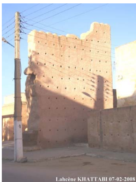
Photo 8: Portion de la Muraille. (Source : Auteur)
