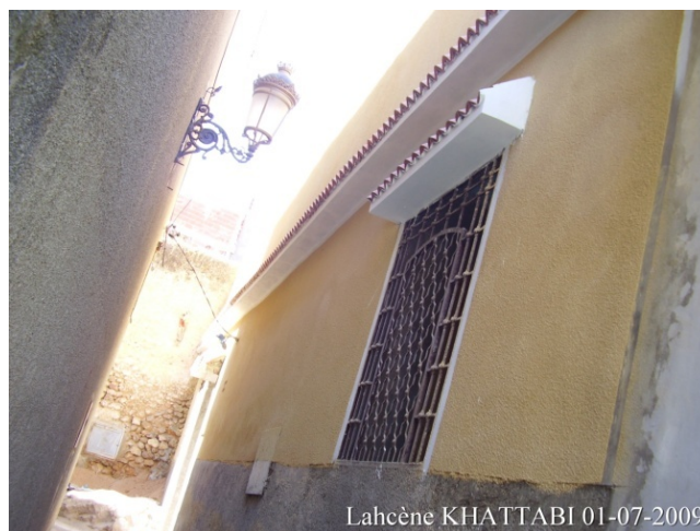
Photo 42: Maison réaménagée et réhabilitée sans aucune norme. (Source : Auteur)
