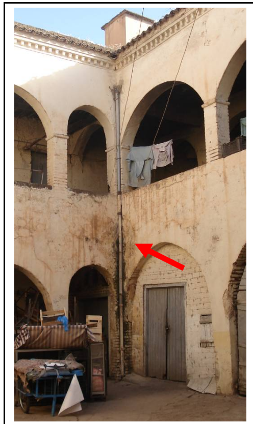
Photo 51: Trace d'humidité au sein du fondouk Source auteur
