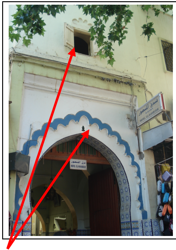
Photo 60: Ornementations à l'entrée du fondouk. Source auteur
