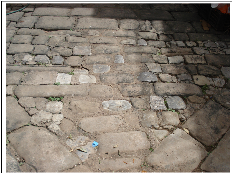
Photo 68: Pavage au niveau du patio Source auteur
