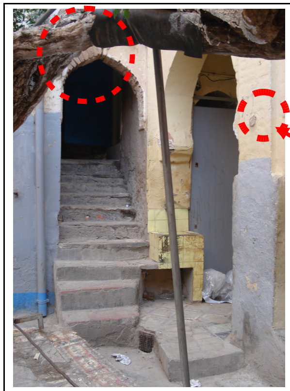
Photo 75: Dégradation du mortier de jointement et éclatement de l'enduit. Source auteur
