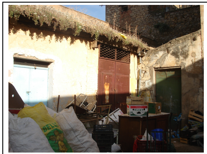
Photo 41: patio du fondouk Source auteur
