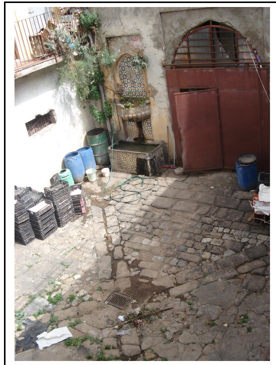
Photo 35: patio du fondouk. Source auteur
