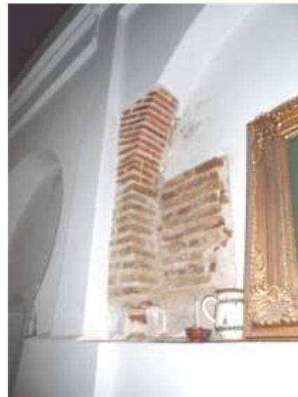
Figure 96: l'utilisation de la brique dans la construction des arcs à l'intérieur de la mosquée.
