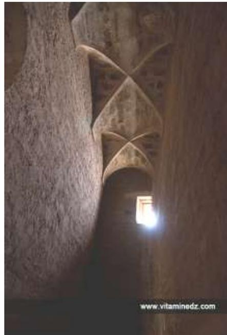
Figure 84: les voutes d'arrêtes rampantes couvrant l'escalier.
