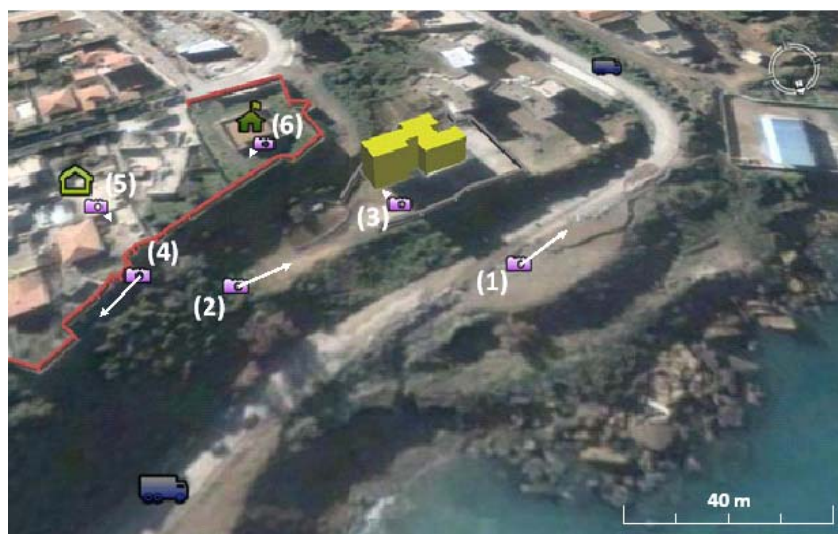
Figure 4.11 Points d'observations des désordres survenus sur le site
