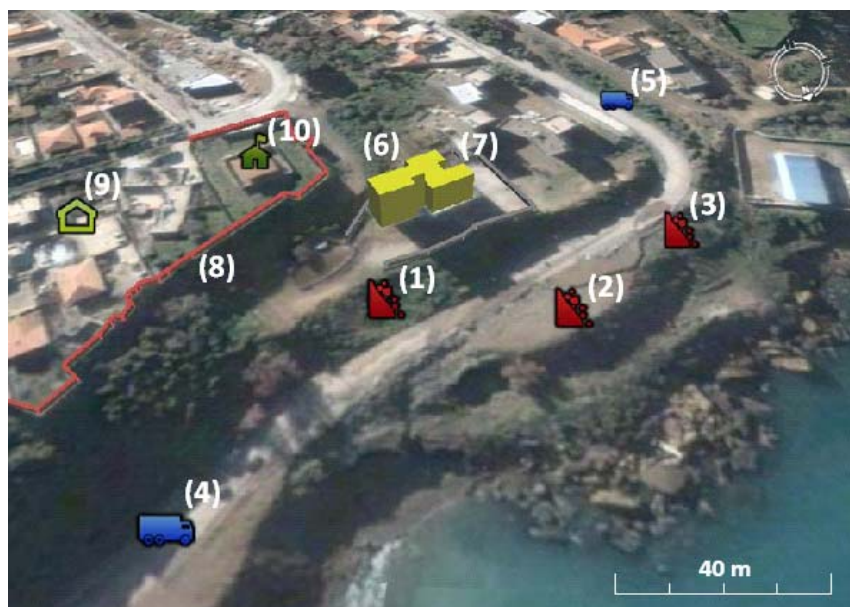
Figure 4.2 Présentation du site, et ouvrages menacés (1) talus A, (2) talus B, (3) talus C, (4) route vers le port, (5) route vers le centre ville, (6) bâtiment A, (7) bâtiment B, (8) muraille, (9) habitations individuelles, (10) musée historique
