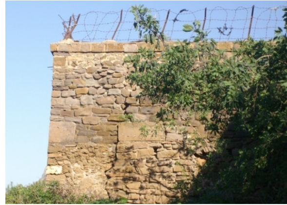
Figure 4.15 Point d'observation 4, orientation nord-ouest
