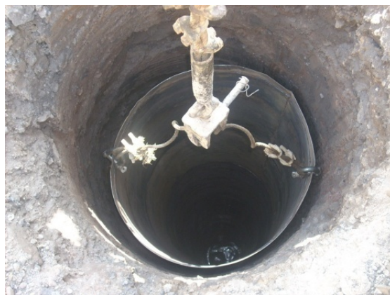
Figure 6.2 Coffrage métallique pour la réalisation des pieux
