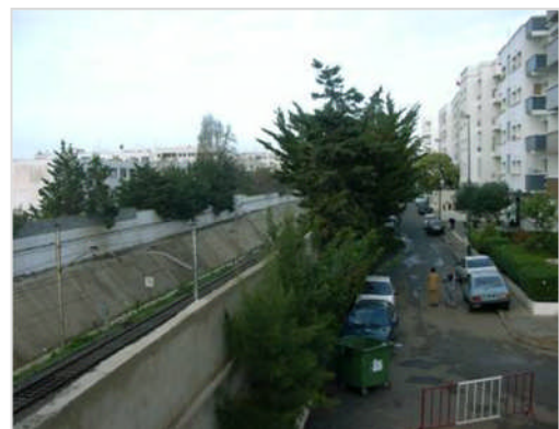
Image : Le deuxième tronçon au niveau du bas Agdal où les immeubles résidentiels en R+4 sont omniprésents.
