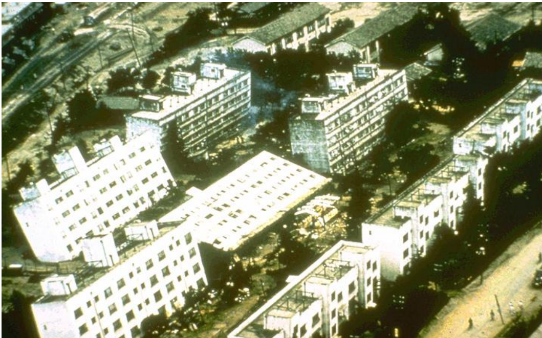
Figure 1.6 : Schéma d'une liquéfaction du sol et renversement des bâtiments résultant de séisme de (NIIGATA, JAPON, 1964)
