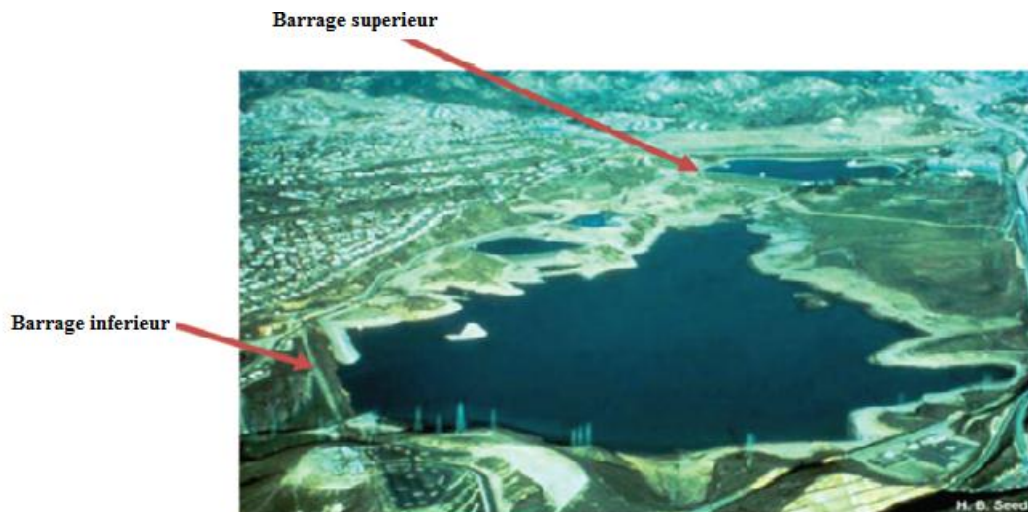
Figure 1.9 : barrage de San Fernando ( ZEROUAL ABDELLATIF, 2009 )
