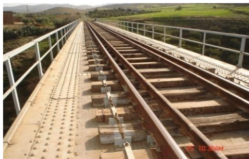
Photo 5.3 - Vue générale du tablier.
