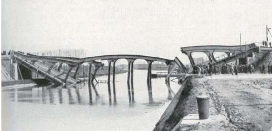
Photo 3.1 - Effondrement soudain d'un pont en raison de rupture fragile. Belgique 1938
