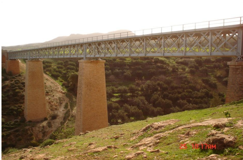
Photo 5.2 - Vue générale du pont.
