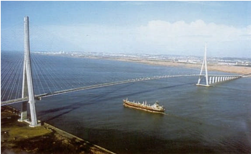
Photo 2 : Ouvrages implantés en site maritime en NORMANDIE [2].
