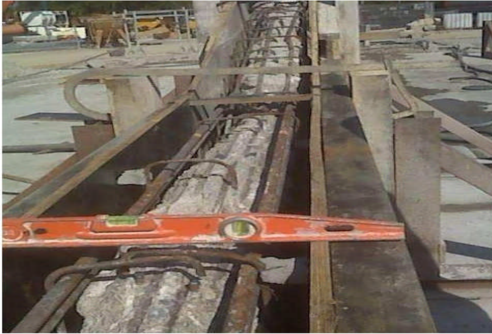
Figure II.18 : Projection par béton coffré [GRO 2001].
