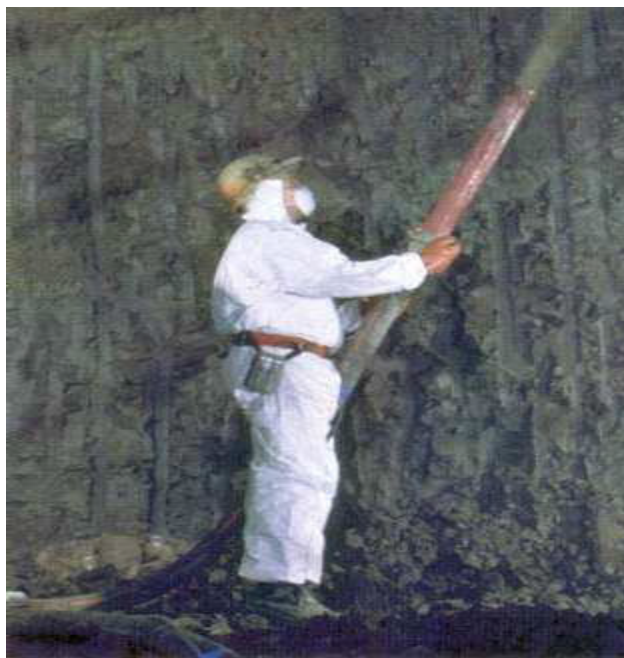
Figure II.16 : Projection par voie sèche [1].
