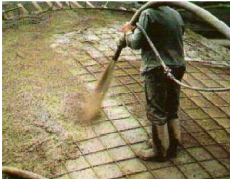
Figure II.17 : Projection par voie humide [2].
